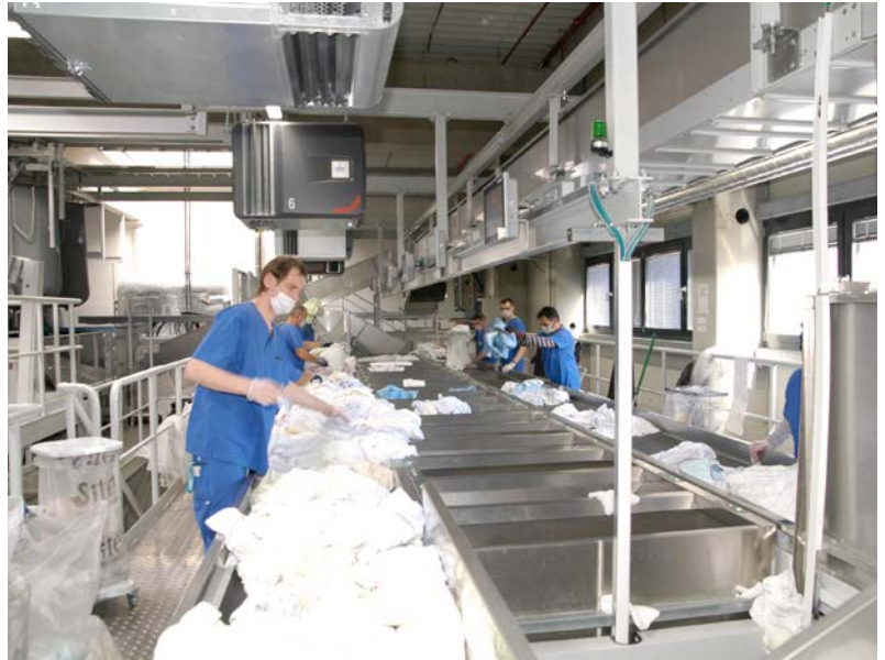
Riesige Luftfilter über dem Schmutzwäschesortierstand sorgen dafür, dass sich die Geruchsbelastung für die Mitarbeiter in Grenzen hält.
